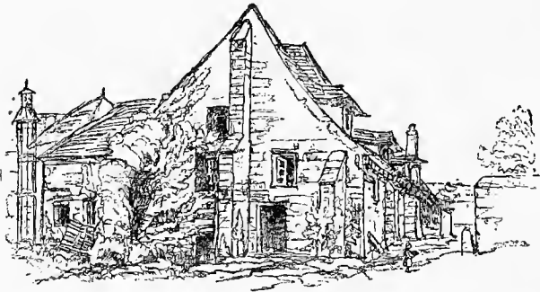
FIFTEENTH-CENTURY MILL (ABBAYE DU VAL).
